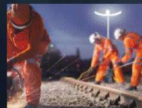
夜間の鉄道保守工事
