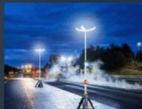
夜間の道路工事
